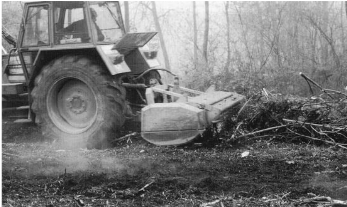
Abb.101: Forstmulchgerät am Schlepper mit 2,3 m Arbeitsbreite, rückwärts arbeitend (JEDICKE 1996, 231)
