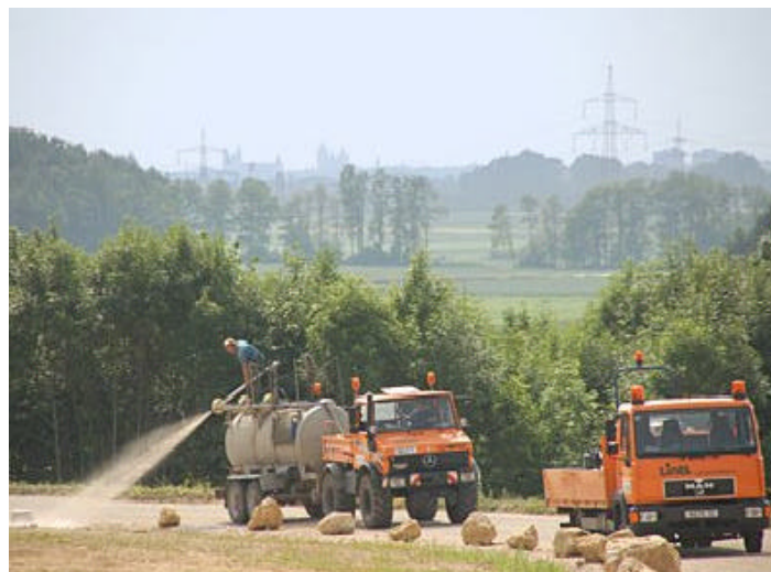
Abb.45: Beispiel für eine Hydroansaat (LINTL LANDSCHAFTSBAU GMBH, online)
